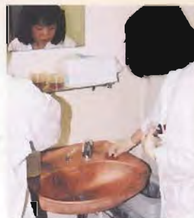
病室内の銅製洗面台
