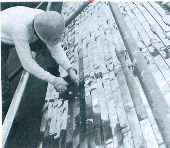
銅板ぶきの屋根構法として、一文字ぶきは昔から最も一般的に利用されている構法で平ぶきとも呼ばれている。
