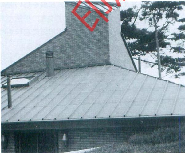
瓦棒ぶき屋根の軒先を銅板ぶきにしたものを腰ぶきといい、短尺瓦棒ぶきは原板幅の定尺銅板を図のように加工し、流れ方向は1,212mmの長さのままはぜ折りして継手を設けてふきあげる構法で、長尺瓦棒ぶきは原板幅の銅条を同様に加工した上で、流れ方向の長さは6m以内に継手を設けふきあげる構法である。
